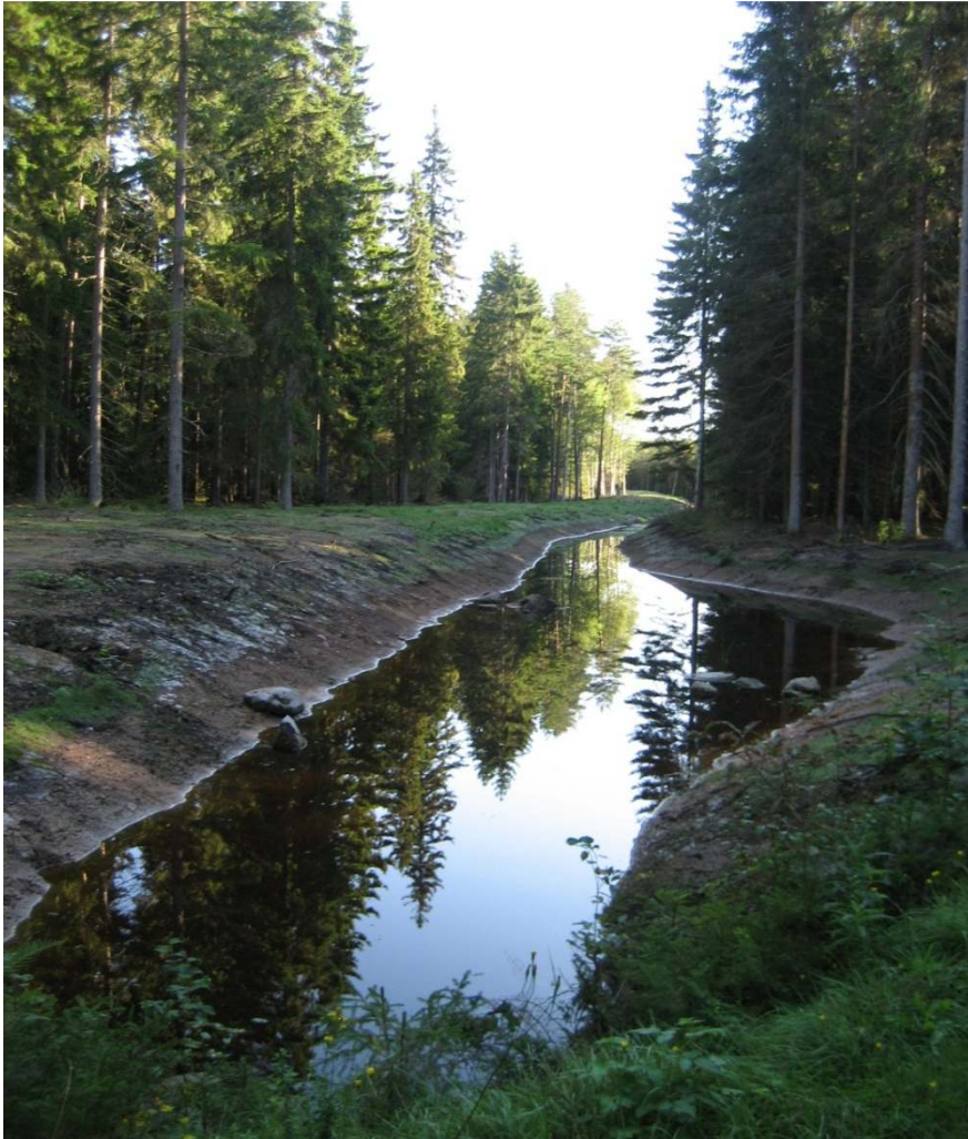
Bild över befintlig dagvattendamm med sedimentering och oljeavskiljning redovisad på föregående karta
